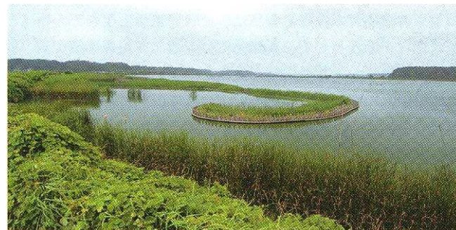
緩傾斜護岸法による試験施工区
